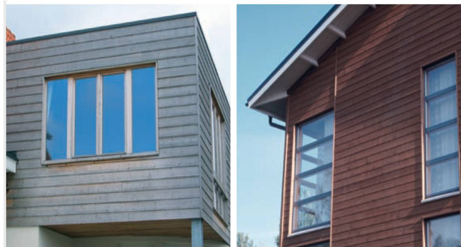
Copertura in ThermoWood dopo tre anni di esposizione agli agenti atmosferici (con e senza pittura)
