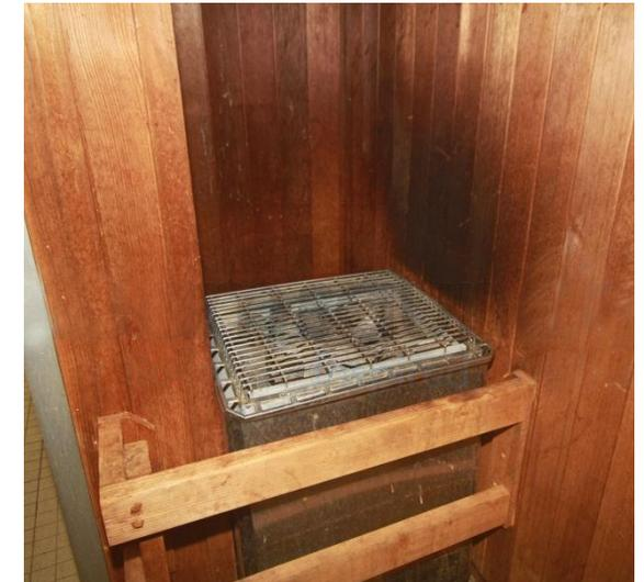
Un esempio di come il calore danneggia le parti intorno alla stufa
